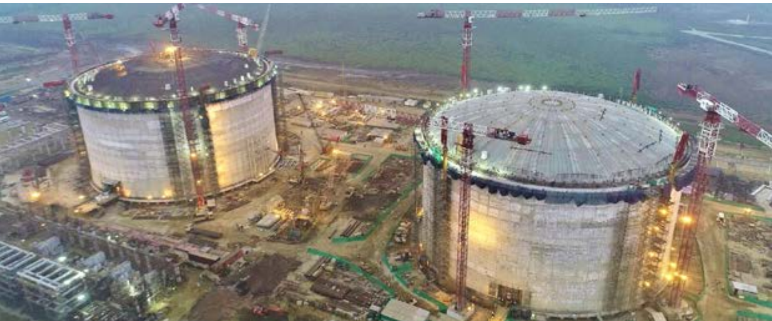
LNG Tanks under construction for Adani's Dhamra LNG Terminal
