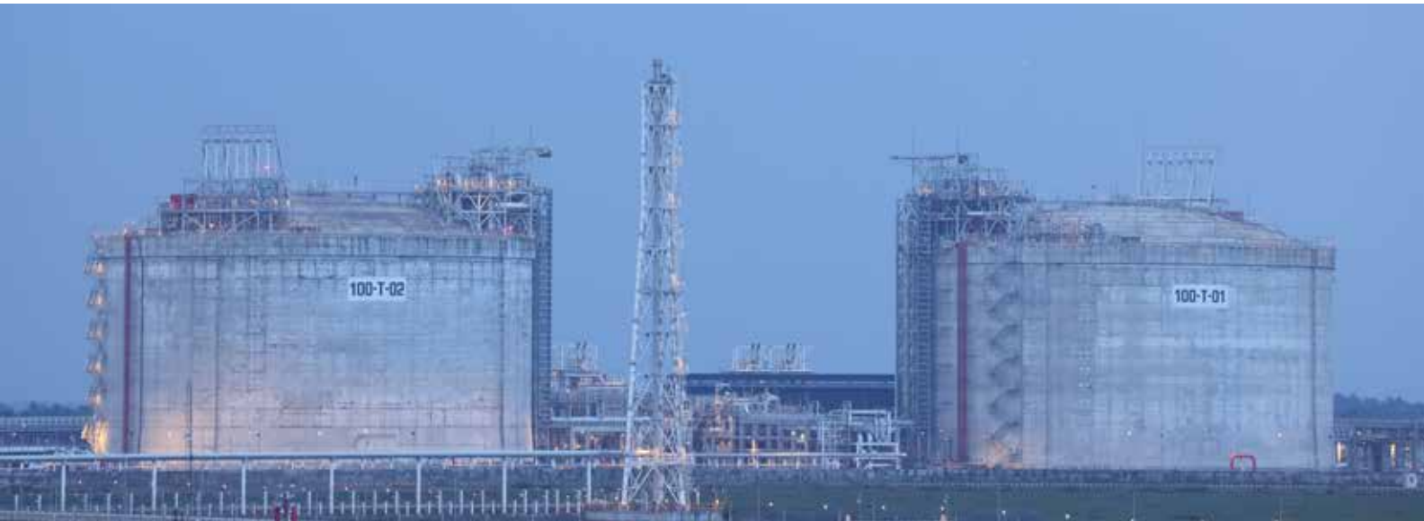
LNG Storage Tanks for Adani Dhamra LNG Terminal, Odisha
